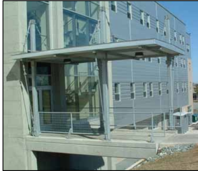
Figure 12.7: Université de Sherbrooke Pedestrian Bridge.
